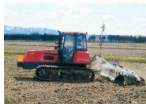
トラクター＋レーザー レベラーによる均平作業
