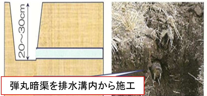
(弾丸暗渠の施工の様子)
