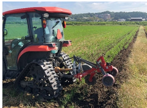
(弾丸暗渠の施工の様子)
