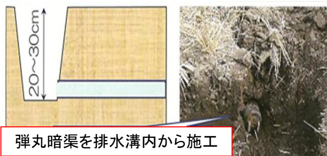
(弾丸暗渠の施工の様子)
