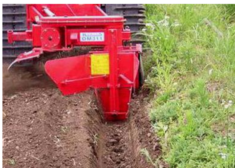
トレンチャーによる額縁排水溝の設置
