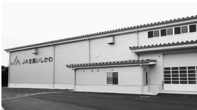
津幡米穀連合倉庫
