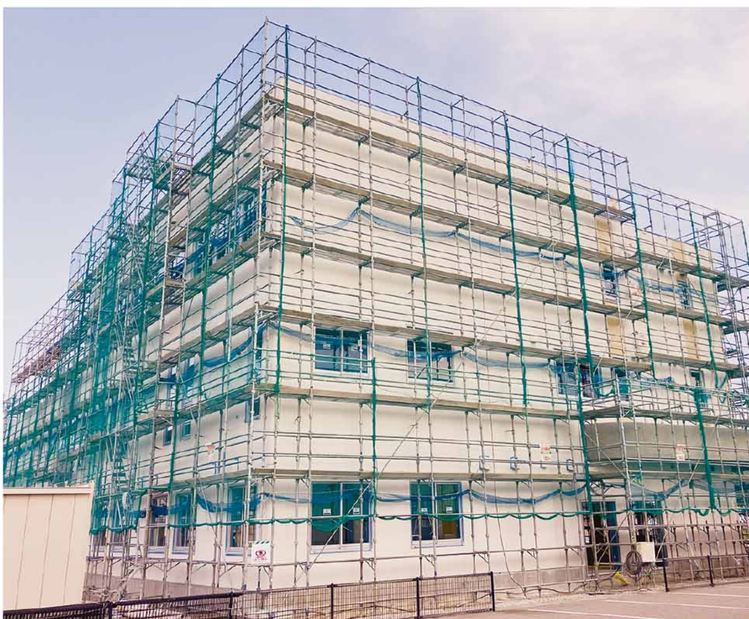
2024.03 「1階 柱 耐火塗装」 「1・2階 サッシ取付」 「2・3階 カーテンウォール取付」
