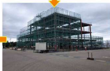
2024.01「デッキ敷設」「外部足場組立」 「1階土間コンクリート打設」 「屋上コンクリート打設」
