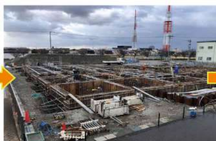
2023.11「基礎配筋」 「浄化槽据付」「コンクリート打設」
