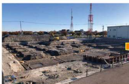
2023.10「杭打設」「基礎掘削」
