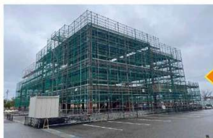
2024.02「2階足場組立」 「屋上設備基礎配筋」 「階段手摺取付」
